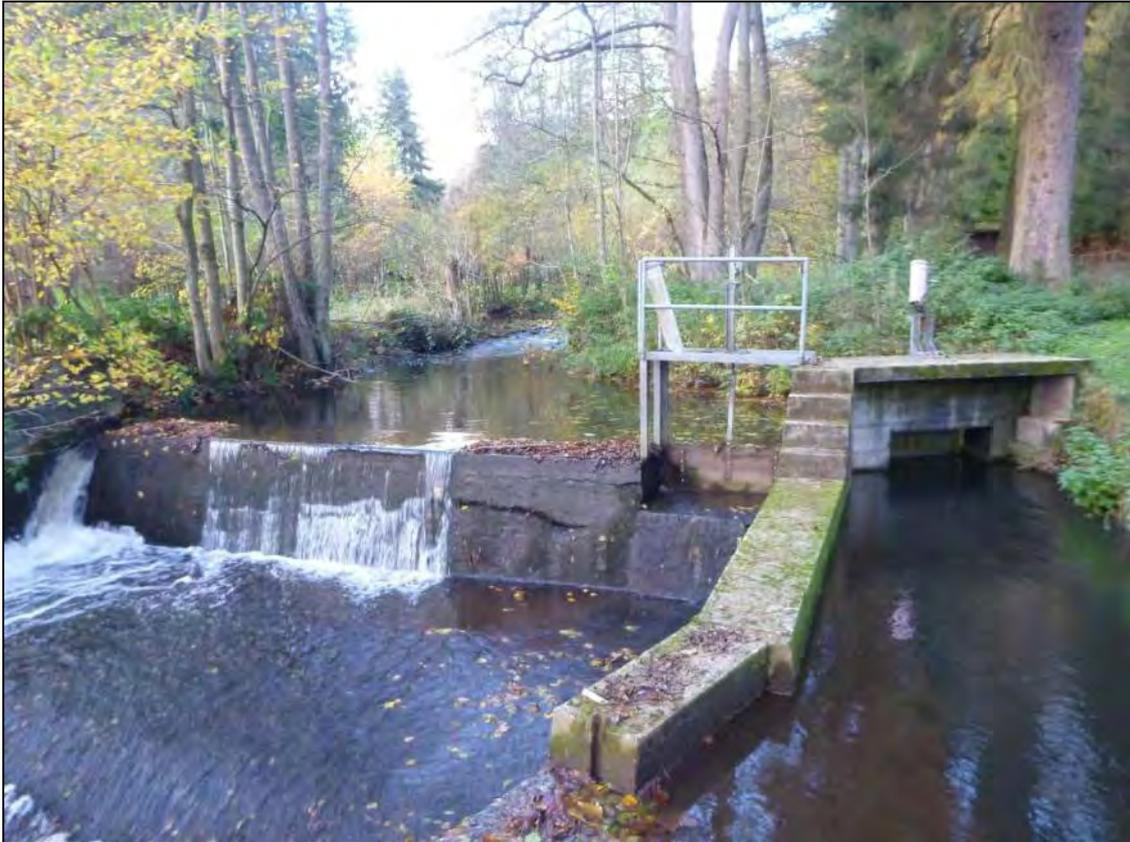
Foto B2-4: Massives Wehr an der Schächtelburg mit einer Sohlabsturz von ca. 2-3 m
