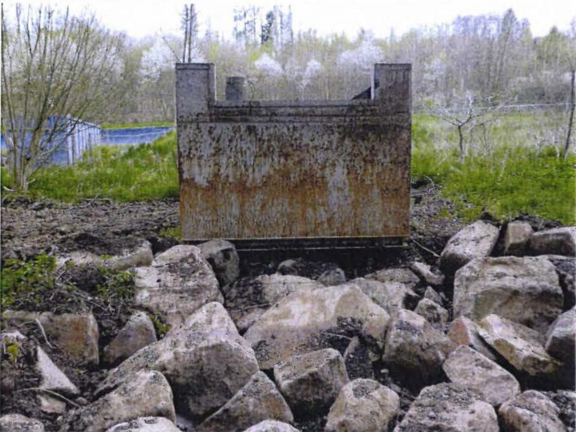
Foto 1: Absetzcontainer mit Überlauf und vorgelagerter Steinpackung über einem Fließ vor Beginn des PV.
