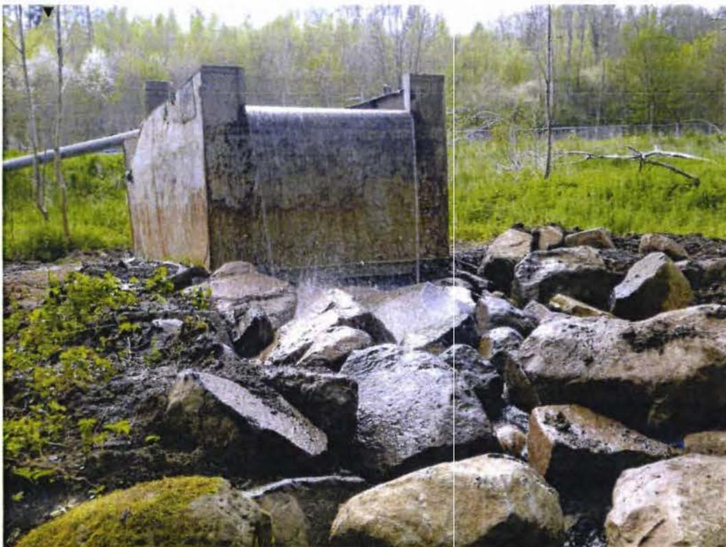
Foto 3: Abfluss von 50 m<sup>3</sup>/h während des PV aus dem Absetzcontainer über die Steinpackung in die Bracht am 02.05.2023.
