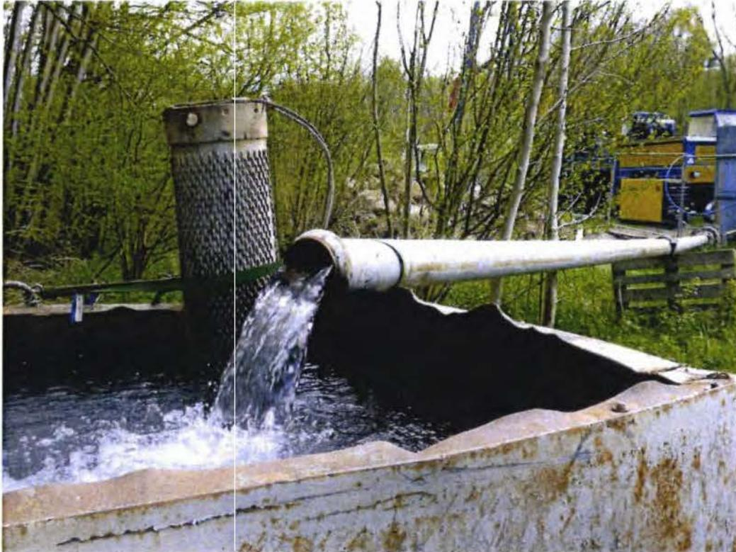
Foto 2: Einleitung von 50 m<sup>3</sup>/h während des PV in den Absetzcontainer am 02.05.2023
